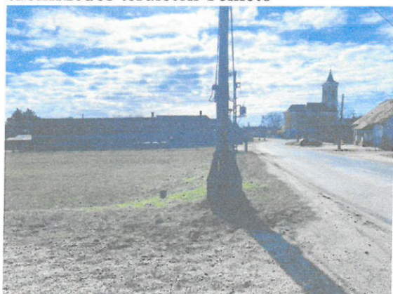
telek nyugati határvonalánál, e-on vezetékek
